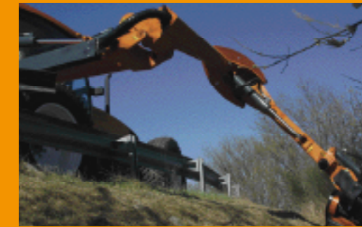
Passage sous flèche
